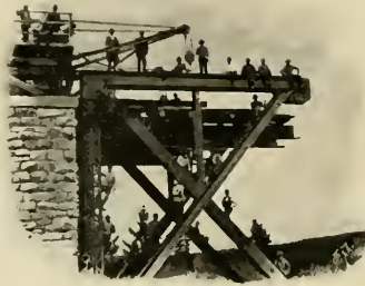
Abb. 150 b. Montirung der Moldaubrücke bei Cervena.
